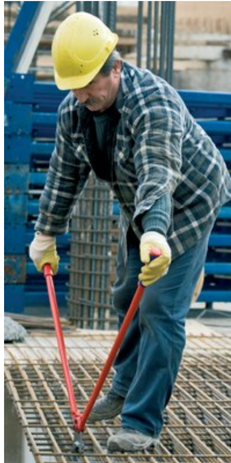
Den speciella huvudformen på armeringsjärnsaxen 71 82 950 gör det möjligt att klippa planliggande byggnadsstål
