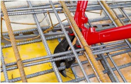
Den speciella huvudformen på armeringsjärnsaxen 71 82 950 gör det möjligt att klippa planliggande byggnadsstål
