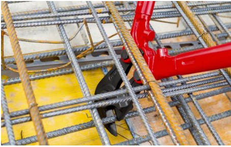
Zvláštní tvar hlavy pákových kleští na pleťivo 71 82 950 umožňuje řezání ploché konstrukční oceli
